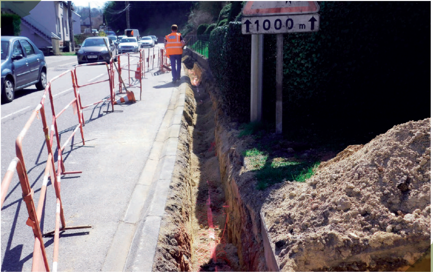
La tranchée du nouveau câblage électrique.
