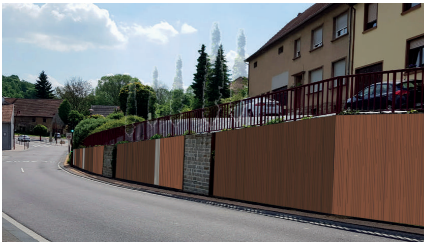
Projet habillage du mur.
