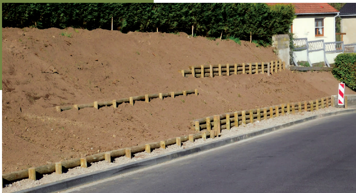
Entrée commune côté Seingbouse.
